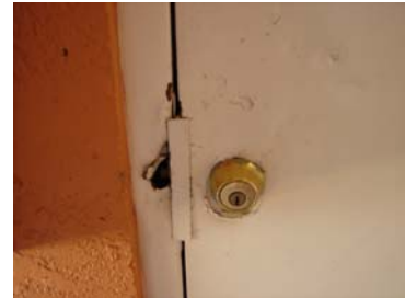
Meter Room Door Lock
