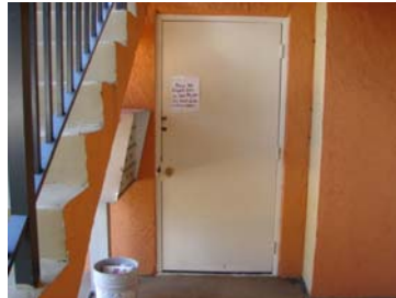
Meter Room Door
